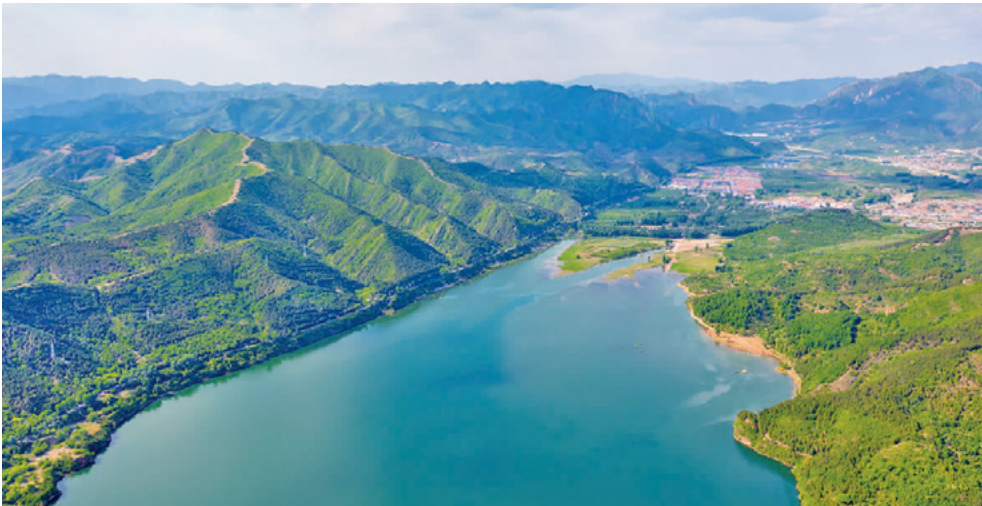
近日，华东公司承建的天津市蓟州区州河国家湿地公园和下营环秀湖国家湿地公园通过国家验收，被授予“国家湿地公园”称号，对保护京津冀重要水源涵养区、完善和优化湿地保护体系，维持和保障地区水生态安全具有重要的战略意义。
