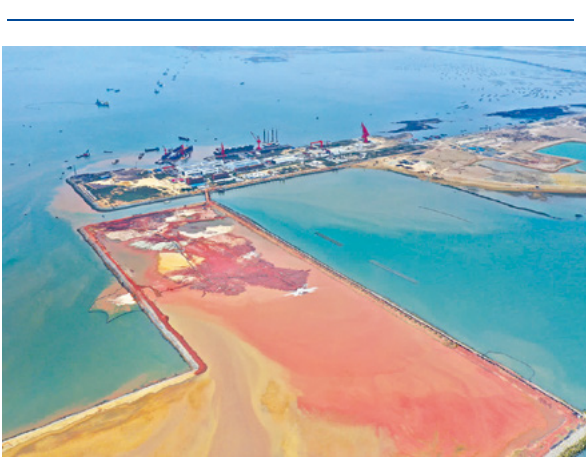
近日，南方公司钦州港东航道扩建工程(扩建 10 万吨级双向航道)一期工程调整项目顺利通过竣工验收，进一步完善了西部陆海新通道和钦州港航运交通体系，加快推进了北部湾地区港口航道建设。
