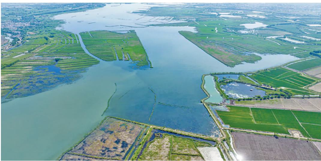
12月27日，白洋淀生态清淤三期工程一标段顺利通过竣工验收。该工程有效改善了居民生活环境，为雄安新区规划建设发展提供了良好的生态环境支撑，也是公司深耕环保治理领域的生动体现。
