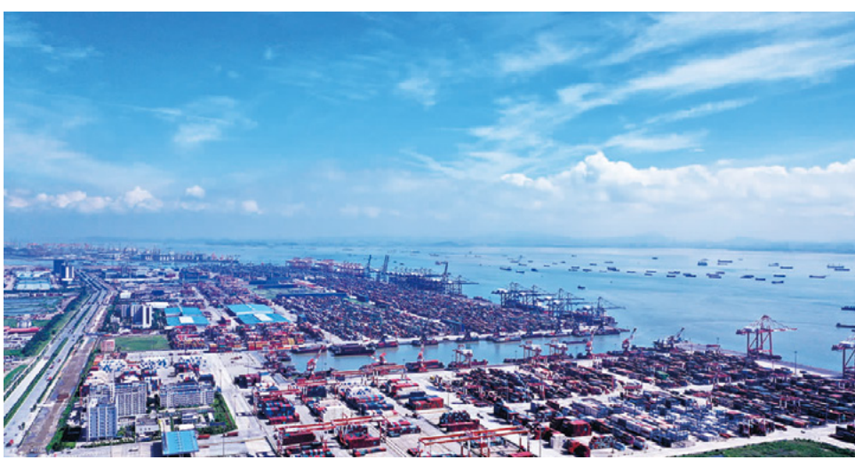
12月17日，广州港出海航道北段维护工程正式开工，工程全长为112.15公里，底标高最深为负13米，疏浚总量186.89万立方米，由“通途”轮负责施工。该工程是广东省2022年重点建设项目，建成后将极大提升广州港航道的通航保障能力。
