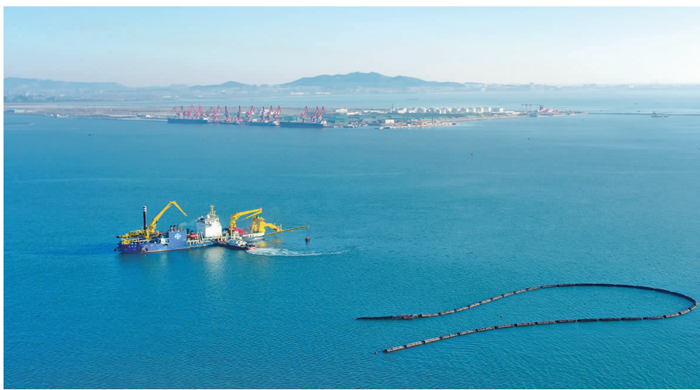
10 月 21 日，“天鲲号”正式投入连云港赣榆港区 10 万吨级航道南延伸段一期工程建设。该工程航道全长 3135 米，通航宽度 190 米，工程疏浚流量 6766 万立方米，是交通运输部“十四五”规划的重点水运建设工程。工程完工后将为黄海粮油科技产业园建设打开海上新通道，助推赣榆经济高质量发展。 图 / 文 赵小康
