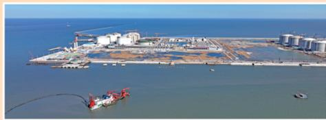
北京燃气天津南港液化LNG应急储备项目采用国内首创的超长吹距大型绞吸船接力吹填施工工艺，为京津冀地区冬季供暖开辟出一条天然气“专属车道”。
